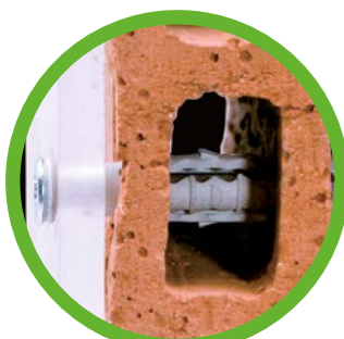
Nessun rischio di deviazione laterale della vite
